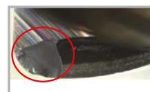
Poškození kvůli slabému břítu
